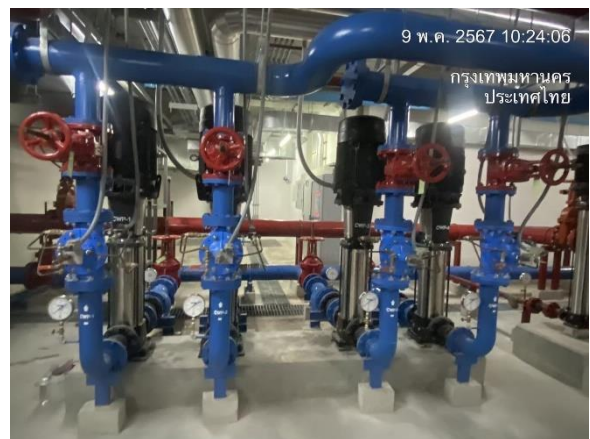
รูปที่ 19 ระบบปั๊มน้ำใต้ดิน
