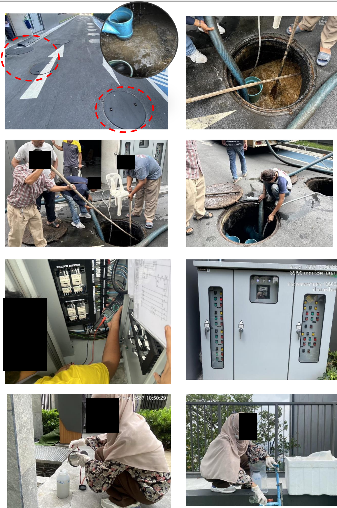
รูปที่ 10.ระบบบำบัดน้ำเสีย การสูบน้ำออกตะกอน และการเก็บตัวอย่างน้ำ
